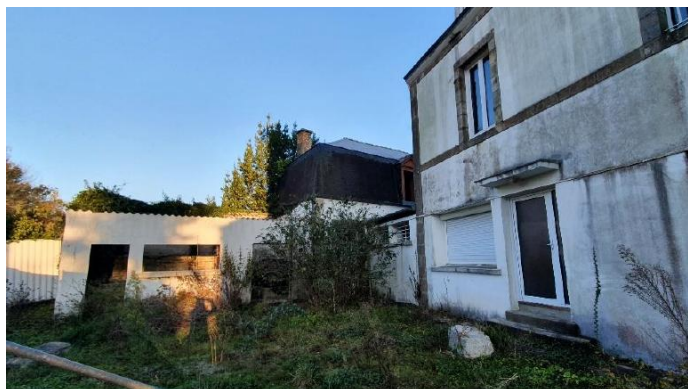
Illustration n°1. Bâtiment B et au fond le bâtiment D appelé à être démoli (Source : diagnostic flash p.5)
