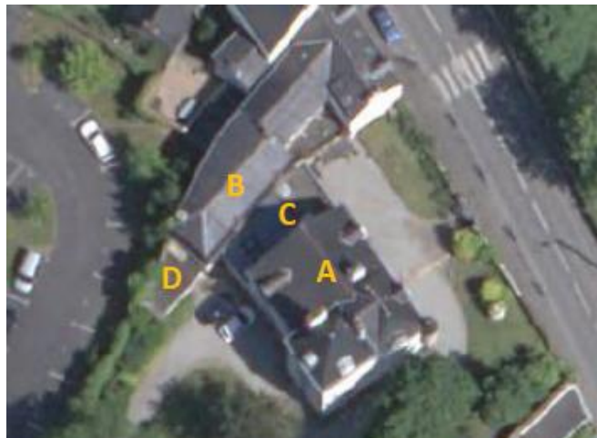
Illustration n°7. Vue aérienne des 4 composantes bâties du site (source : rapport de présentation du dossier de DUP p.9)
