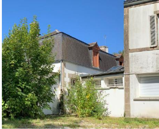
Illustration n°11. Aperçu du bâtiment C entre les A et B (Source : rapport de présentation p.39)
